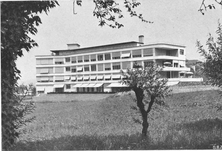
Abb. 1. Erweiterungsflügel des Bürgerspitals Zug, aus Süden gesehen
