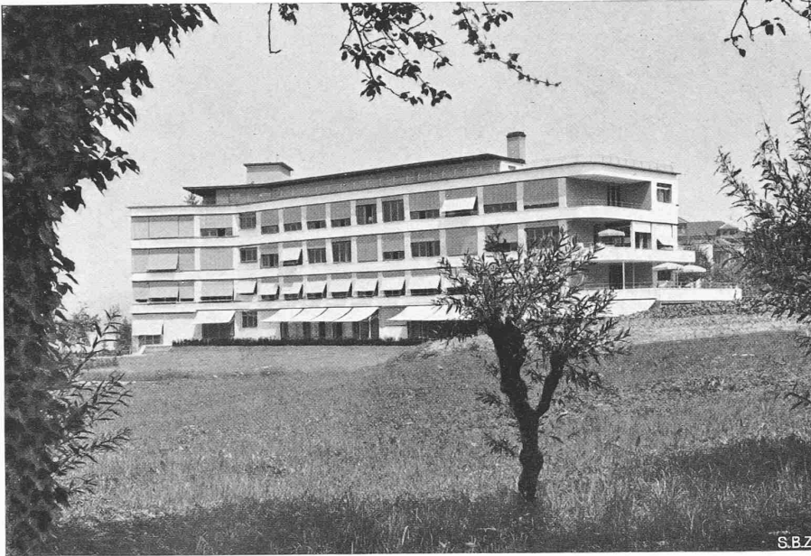
Abb. 1. Erweiterungsflügel des Bürgerspitals Zug, aus Süden gesehen
