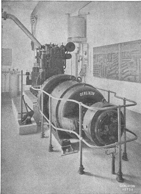
Vollautomatische Diesel-elektrische Notstromgruppe für 130 kVA,
