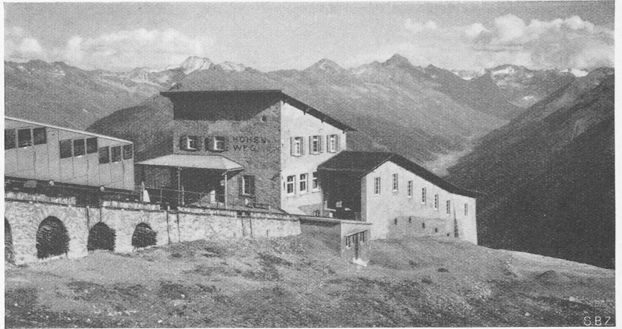
Abb. 28 (rechts) Station Höhenweg, gegen Osten
