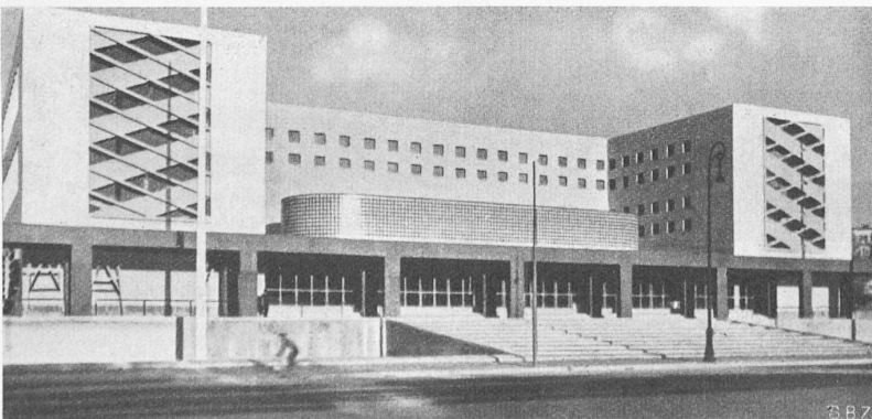
Abb. 7. Postgebäude in Rom. Arch. A. LIBERA und M. DE RENZI
