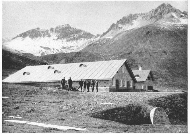
Abb. 2. Stafel Astras im Scarlital, Gemeinde Schuls, 2140 m ü. M. Stall für 80 Kühe, in Linie mit der Sennhütte. Baujahr 1934
