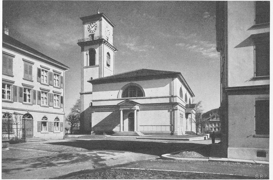
Abb. 6. Die wiederhergestellte Kirche Heiden in Harmonie mit der Platzbebauung
