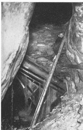
Abb. 12. Alter Abbau im obern «Geisslergang», im Hintergrund oben alter Versatz
