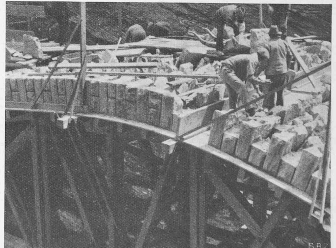
Abb. 6. Gewölbemauerung der neuen zweiten Viamalabrücke
