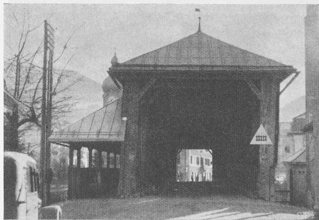
Abb. 2. Durchblick mit flussabwärts angebautem Gehsteg
