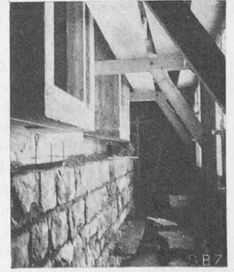
Abb. 14. Betonierte Fenstergewände und Vormauerung
