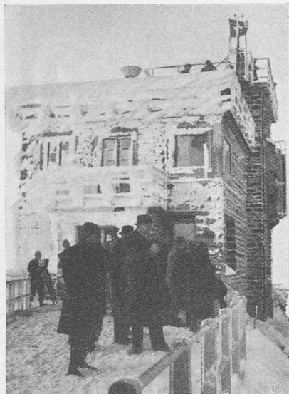
Abb. 19. Sphinx-Pavillon am 31. Okt. 1937
