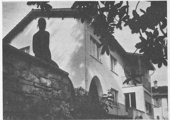
Abb. 65. Haus «Al Ronco» in Lugano. Arch. C. & R. TAMI, Lugano
