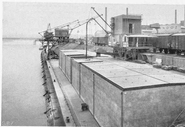
Abb. 14. Teilansicht der Getreidebehälter mit Förderanlage.
