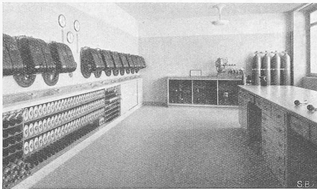
Abb. 15. Gasschutzgeräteraum im Zwischengeschoss des Hauptgebäudes
