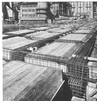
Abb. 14. Schalung und Hauptträger-Armierung (März 1936)
