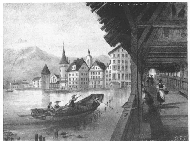
Abb. 1. Die alte Hofbrücke, hölzerne Jochbrücke, gegen Westen
