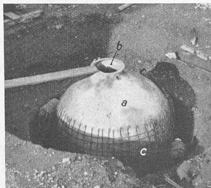
Abb. 4 (mitte). Kugelschale in der Baugrube versetzt. a Kugelschale in Gunit, b Einsteigöffnung, c eine Lage Armierungseisen der Betonumhüllung
