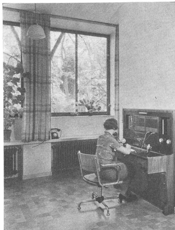
Vermittlerschrank für 10 Amtsleitungen
