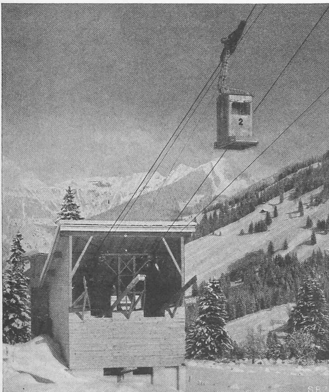
Abb. 6. Talstation auf der Stöckalp, gegen Nordost.
