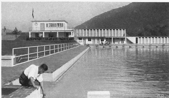
Abb. 2. Links Restaurant, darüber Badmeisterwohnung, rechts Familien- und Damenkabinen.
