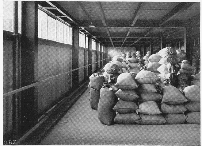
Abb. 7. Im ersten Stock, Kote + 4,12, Fensterwand und Holzboden.
