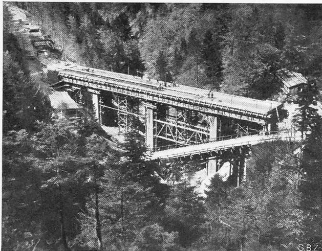
Abb. 2. Bucherbrücke der Deutschen Alpenstrasse, im Bau. Durchlaufender Eisenbetonbalken über 4 Oeffnungen von 15,2 + 21,4 + 21,4 + 15,2 m, 2 Hauptträger von 2,2, bzw. 2,4 m Höhe, 0,42 m stark, ohne Vouten, dafür an den Auflagern auf 0,72 m verbreitert. Trägerabstand 5,7 m, Fahrbahn 9 m breit.
