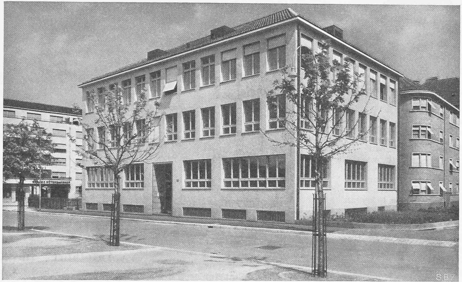
Abb. 1. Ansicht aus Westen mit Eingangsfront an der Hermann Greulichstrasse.
