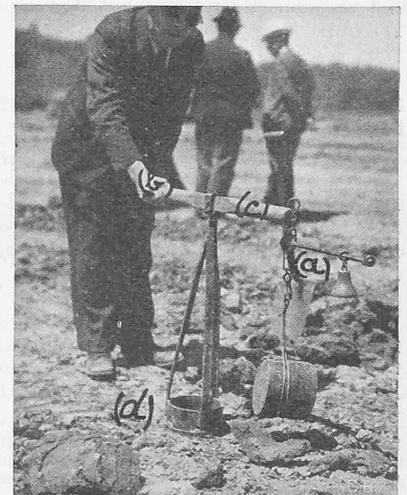
Abb. 10. Verdichtungsmass-Prüfapparat.
