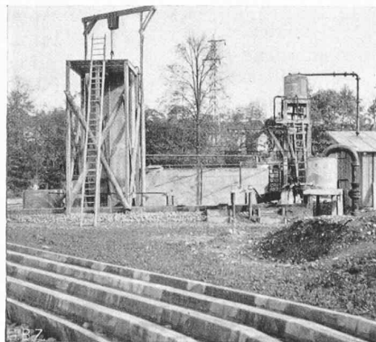
Abb. 2. Gesamtbild der Versuchsanlage.
