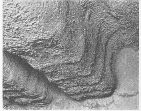
Abb. 4 bis 6. Durach-Eindeckung in Schaffhausen; Decken-Untersicht vor, während und nach der Instandstellung durch Gunit.
