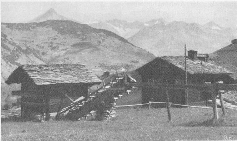
Alte Walliser Mühle mit hölzerner Druckleitung in Grächen (Vispताल).
