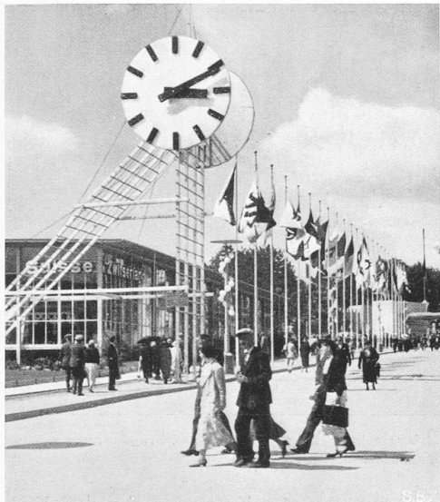
Abb. 13. Uhr auf Antikorodalgerüst, Fahnenreihe, dahinter die Maschinenhalle.
