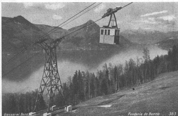
Giesserei Bern Fonderie de Bern 383
