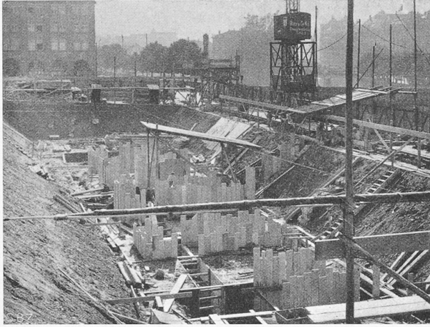
Abb. 16. Ausschachtung für die I. Etappe der Fundamentschwellen.
