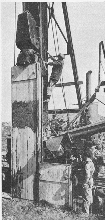
Abb. 1. Betonieren der ersten und Ansetzen der zweiten Rammform. Abb. 2. Gesamtbild der Maschine.
