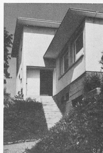
Abb. 3. Eingang und Garage-Zufahrt.
