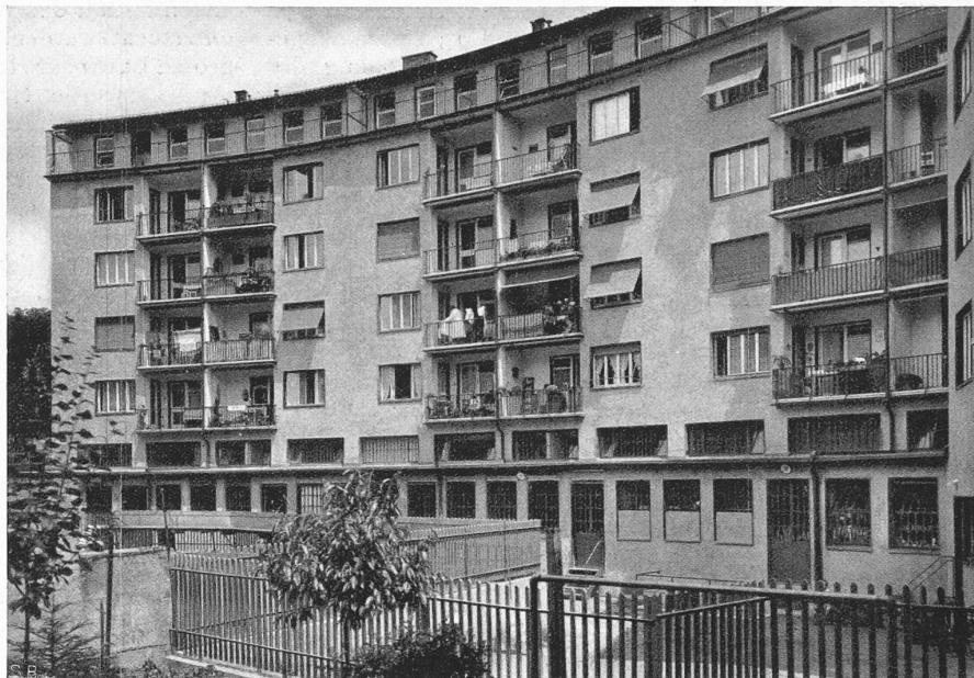
Abb. 3. Hofseite des Hauptflügels. Die breiten Fenster belichten die innern Lagerräume (Schnitt C-D).
