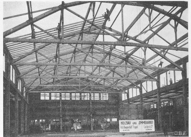
Abb. 10. Montage des hölzernen Hallendaches.
