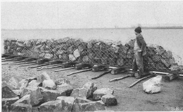
Abb. 16. Bruchstein-Senkwurf, bereit zum Abwerfen von der Senkbrücke.
