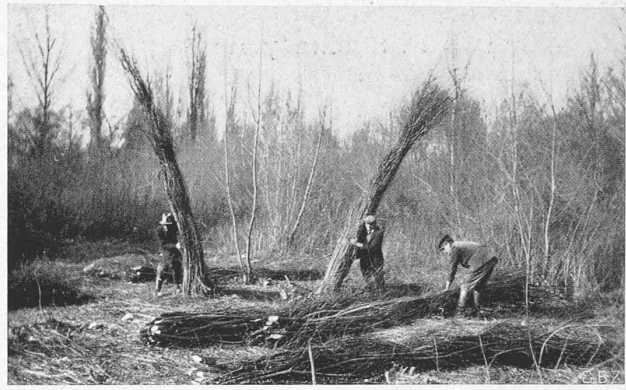
Abb. 17. Faschinenbinden im Unterholz der Rheinniederungen.
