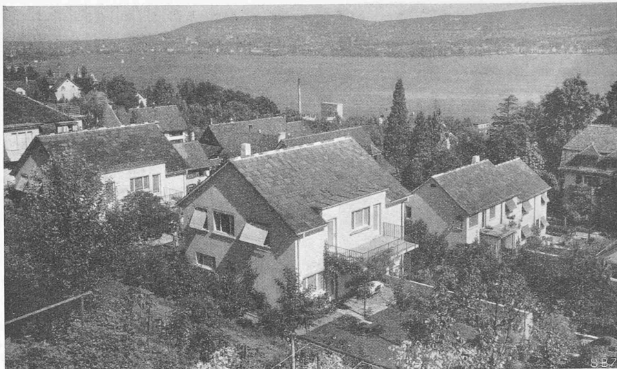
Abb. 3. Häuser an der Kilchbergstrasse, nordwestlicher Teil der Gruppe, aus Süden, vorn Typ D.
