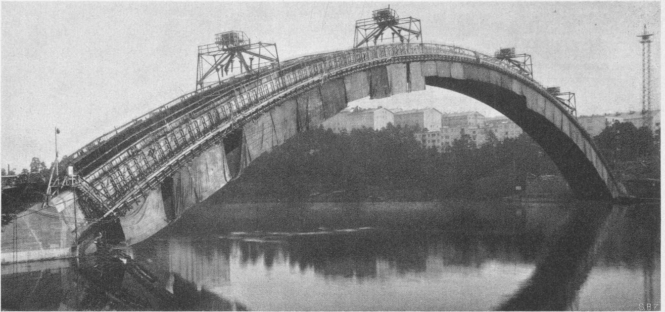
Abb. 10. Betonieren des ersten Bogens mit vier verstellbaren Gerüsten; das stählerne Lehrgerüst durch nasse Tücher vor Sonnenbestrahlung geschützt.
