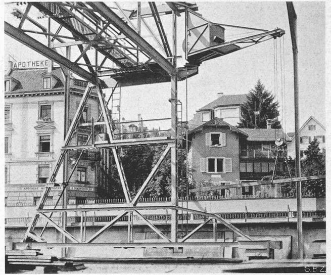
Abb. 4. Pendelstütze mit schwenkbarem Ausleger (Strassenseite).
