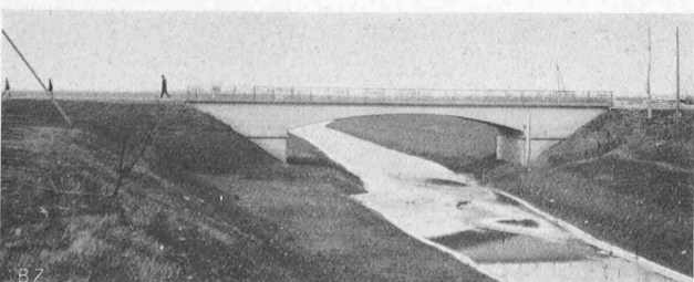
Abb. 5 und 6. Ein Hauptkanal der Bonifica Parmigiana-Moglia.
