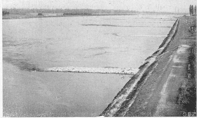
Abb. 10. Ausgebaute Buhnenreihe am rechten Ufer bei Marlen, bei Niederwasser, Q 478 m 3 /sec, bad. Km. 118 bis 119 (26. März 1932).
