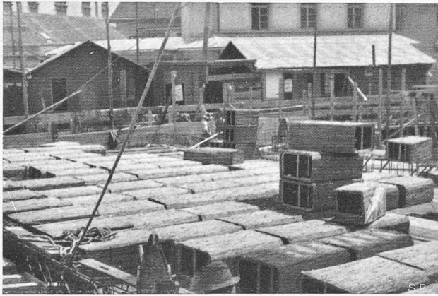
Abb. 39. Verlegte Rohrzellen.
