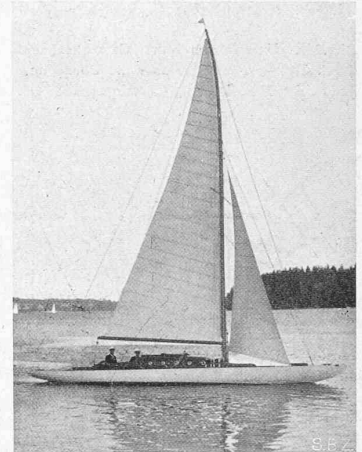
Abb. 36 und 37. 40 m²-Schärenkreuzer (Regattaboot) aus Eisenbeton mit Sika-Zusatz; Wandstärke 10 mm. — Ing. Yberg, Ramvik, Schweden. — Gewicht 1500 kg, d. h. nur 300 bis 400 kg mehr als Holzbau. [Beschreibung folgt 1933.]
