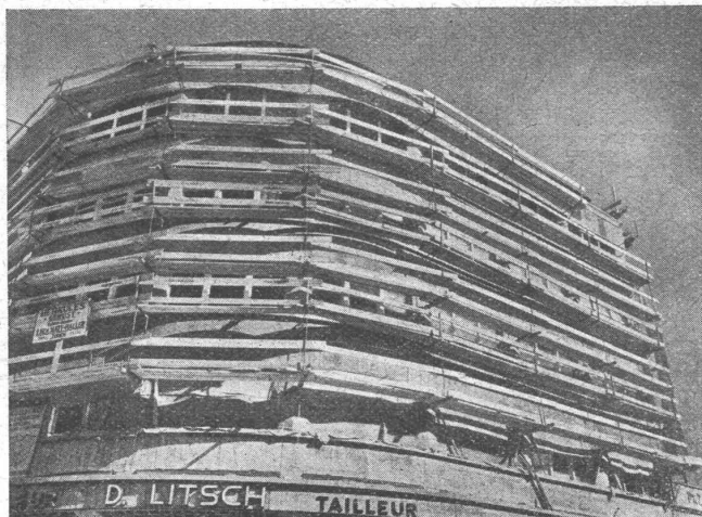
KOLLERHOF MIT HERKULESGERÜST
