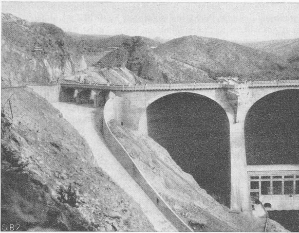
Abb. 1. Rechtsufriger Hochwasserüberlauf der Coolidge-Staumauer (U. S. A.).
