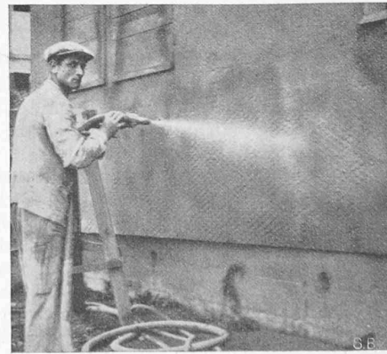
Abb. 15 bis 17. Aussenverschalung im Bau, mit Dachpappe überzogen, mit Streckmetall überspannt und mit Zementmörtel („Gunit“) bespritzt.
