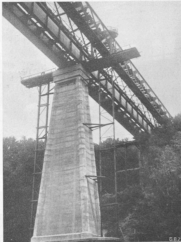
Abb. 2. Neuer Träger eingeschoben, ummantelter alter eiserner Pfeiler.
