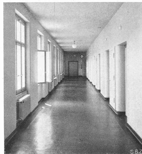
Abb. 14. Korridor eines Bettenflügels.
