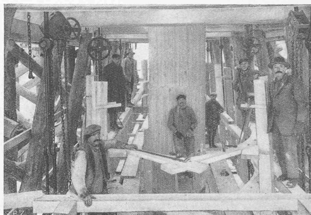
Abb. 5. Aufbau der Pfeilerschalung im Spindelgerüst.
