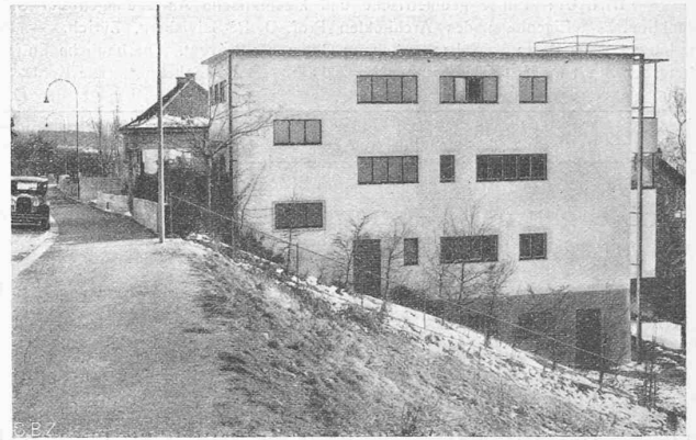
Abb. 2. Nordwestfassade des Hauses Salvberg (umgekehrt wie Abb. 1).
