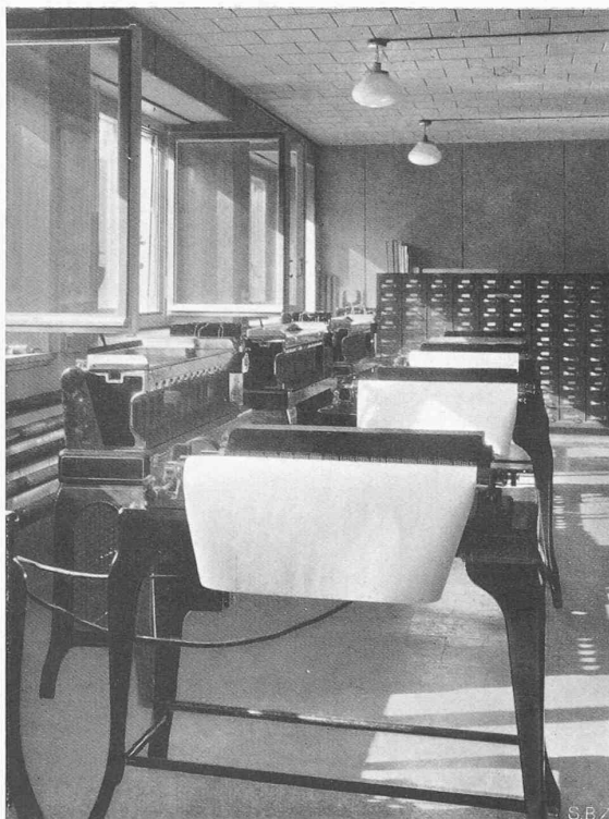
KARTENLOCH- UND ZÄHLMASCHINEN FÜR DIE VOLKSZÄHLUNG DECKEN-VERKLEIDUNG MIT AKUSTIK-CELOTEXPLATTEN, BODENBELAG EXPANKO-KORKPARKETT
