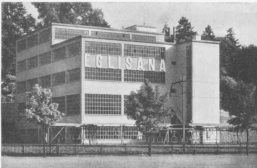
Abb. 4. Gesamtbild von der Bahnseite, aus Norden.
