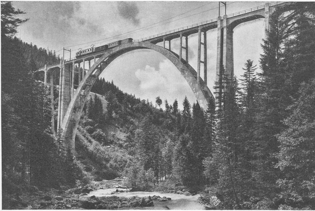
Abb. 2. Eisenbeton-Bogen von 100 m Spannweite des Langwieser Viadukts.
