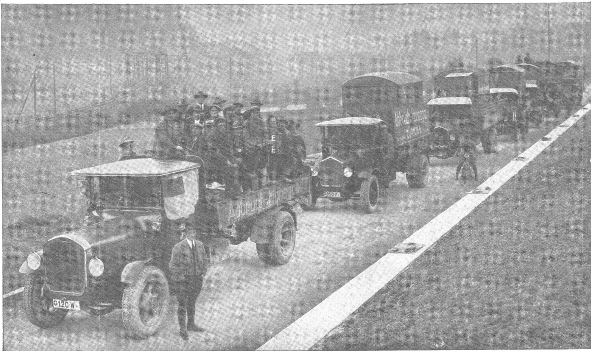
Sieben BERNA Klipper der aus zwölf BERNA bestehenden Kolonne für Abbrucharbeiten.
